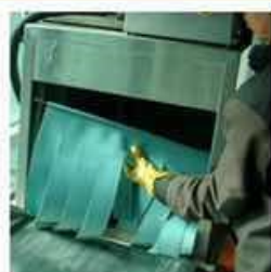
拆卸、清洗、安装挡水帘
