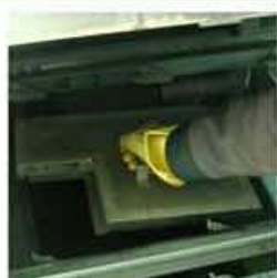
拆卸、清洗、安装过滤板
